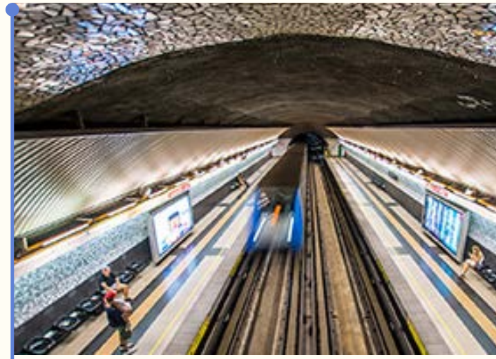
Se ponen en servicio las estaciones Cementerios y Einstein de la Línea 2 hacia el norte, y los primeros tramos de la Línea 4 entre las estaciones Tobalaba y Grecia (subterráneo), y Vicente Valdés y Plaza de Puente Alto (en viaducto).
