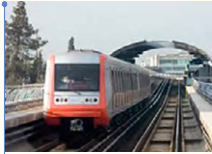
Se inicia la construcción de la Línea 4 hacia Puente Alto.
